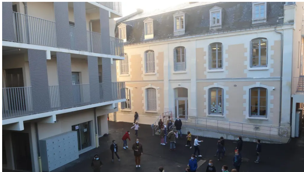
Le bâtiment historique et les nouveaux dont celui jouxtant la rue Noirmant.
