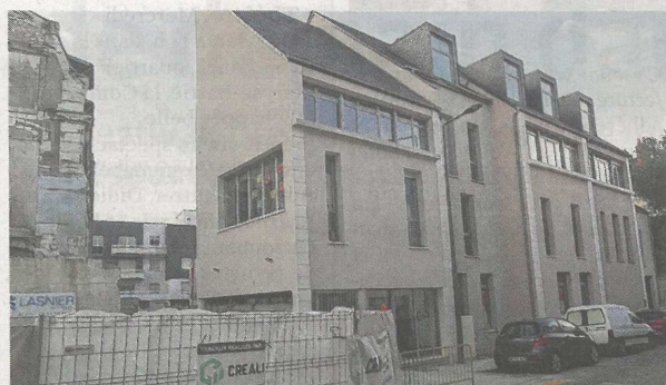
Rue Noirmant, les nouveaux locaux qui accueillent aujourd'hui les écoliers et, à partir de la rentrée prochaine, les collégiens.
