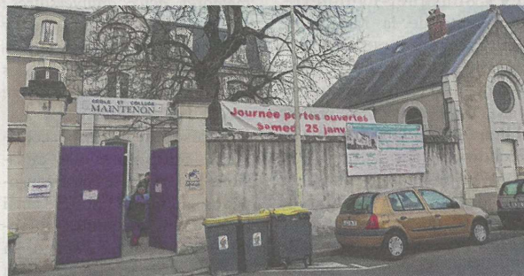
Dès lundi, commenceront les travaux sur les bâtiments de la rue Marcel-Tribut.
